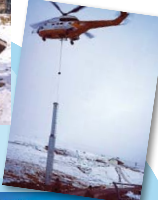
Pose d'un pylône du télécabine de Poutran, 1988.
