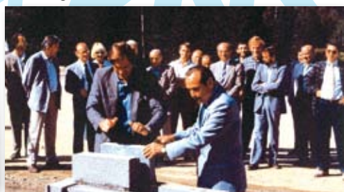
La pose de la première pierre de la station, 1988.
